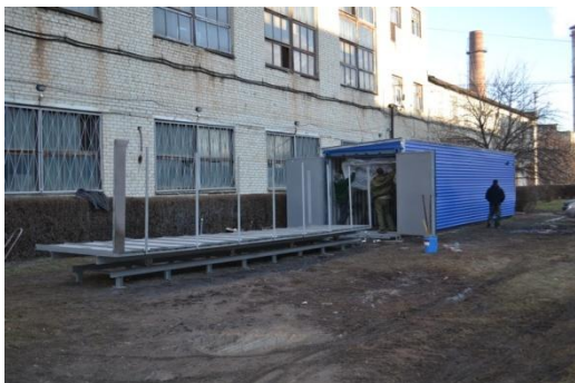
Рис. 2а .Подштабельная тележка на выкатных путях.
