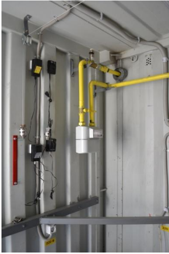
Рис 9. . Измерение усадки штабеля. Приборы контроля загазованности , термозащиты и учёта расхода газа.
