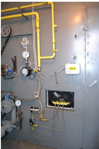
Рис. 10а . Общий вид перегородки комнаты управления.
