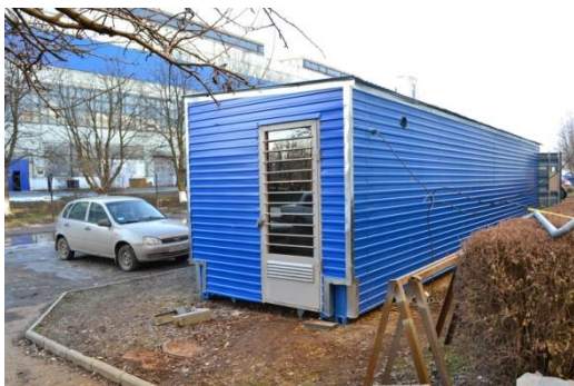
Рис. 1а .Внешний вид со стороны комнаты управления.
