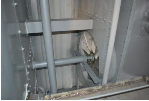
Рис. 6а . Длинный вал маршевого вентилятора.
