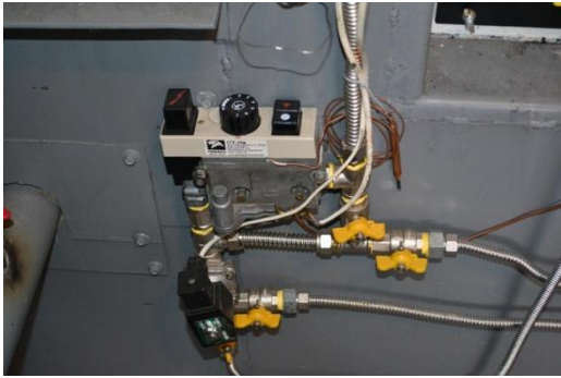
Рис. 9а . Блок управления газовой горелкой.
